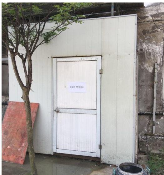
图 4-5 一般固废暂存间
